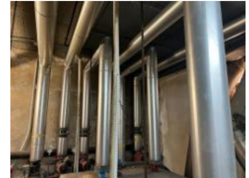
Installation für die Wärmerückgewinnung aus der Kälteanlage zur Nutzung für die Klimaanlage im THB Guya Playa.
