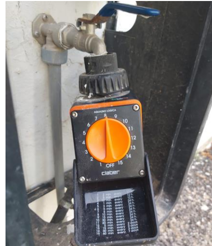
Automatisierung der Bewässerungsanlagen.
