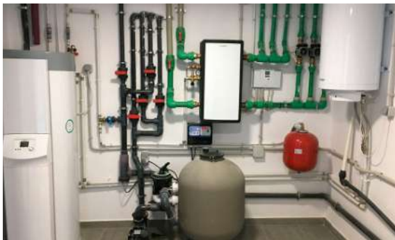
Instalación de aerotermia en THB Guya Playa.
