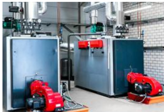
Sostituzione delle caldaie a gasolio con caldaie a condensazione a gas più efficienti.
