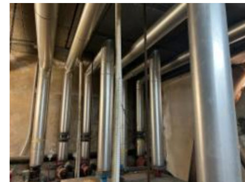
Installazione del recupero di calore, dall'impianto di raffreddamento, per l'utilizzo in ACS, presso THB Guya Playa.
