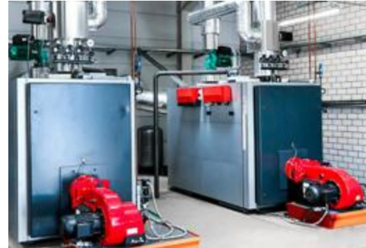
Remplacement des chaudières au fioul par des chaudières gaz à condensation, plus efficaces.
