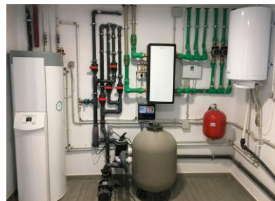
Installation d'aérothermie au THB Guya Playa.
