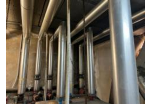
Installation d'un récupérateur de chaleur sur le système de refroidissement pour production d'eau chaude sanitaire au THB Guya Playa.
